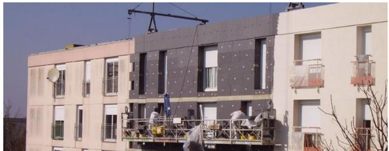
Des panneaux de mousse résolique peuvent également être utilisés à la place de ceux en polystyrène. Ils possèdent une conductivité thermique  $\lambda_{th,MR}=0,022 W \cdot m^{-1} \cdot K^{-1}$
